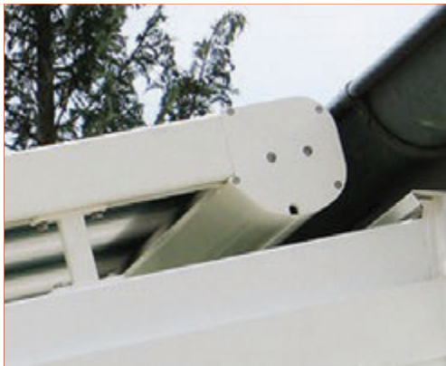
Protección de la lona mediante cofre.
